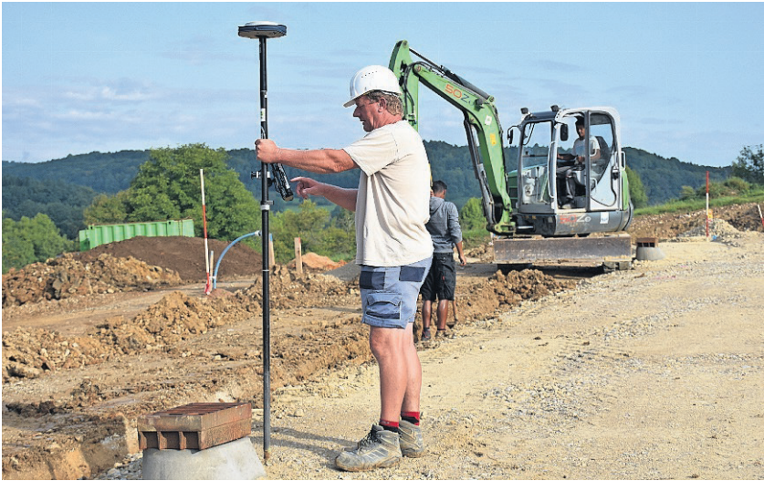
Dank des Einsatzes des Rover-Geo-Stabs gehören Nivelliergerät und Pflöck nahezu der Vergangenheit an.
