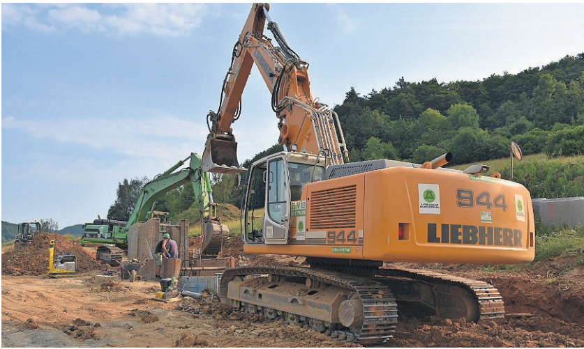
Aktuell erschließt Arbogast im Auftrag der Bayernrund das Neubaugebiet in der Gemeinde Kirchensittenbach.
